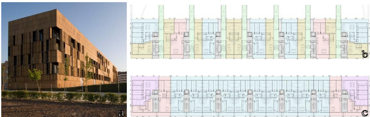
Slika 49: Stambena zgrada u Carabanchelu, Madrid, Španija, Foreign Office Architects, 2007
