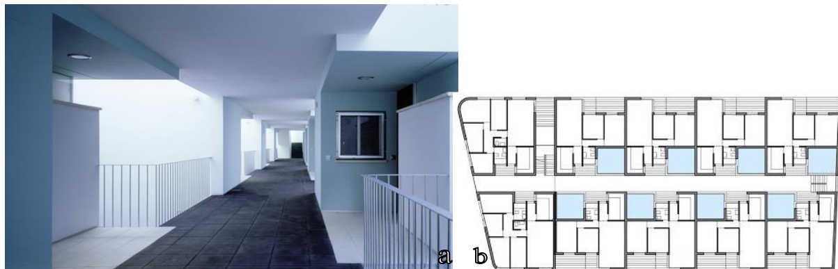
Slika 11: Stambena zgrada, Conil, Španija, Javier Terrados, 1999
