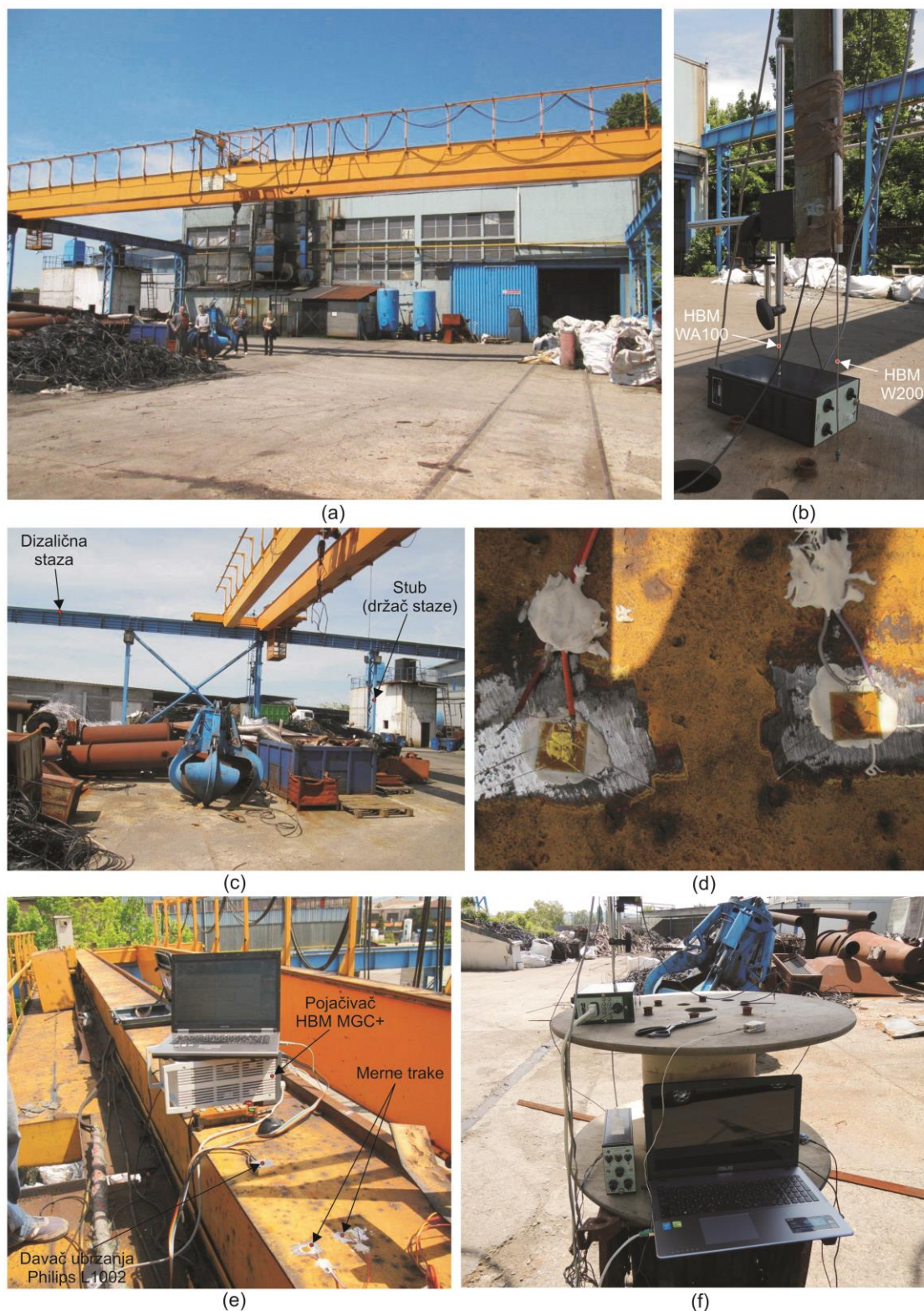
Slika 5.22 Ispitivanje mosne dizalice MIN-D800: (a) postavka dizalice u okruženju, (b) senzori puta oscilovanja, (c) dizalična staza, (d) merne trake na glavnom nosaču, (e) deo mernog sistem na samom mostu, (f) deo sistema za merenje puta.
