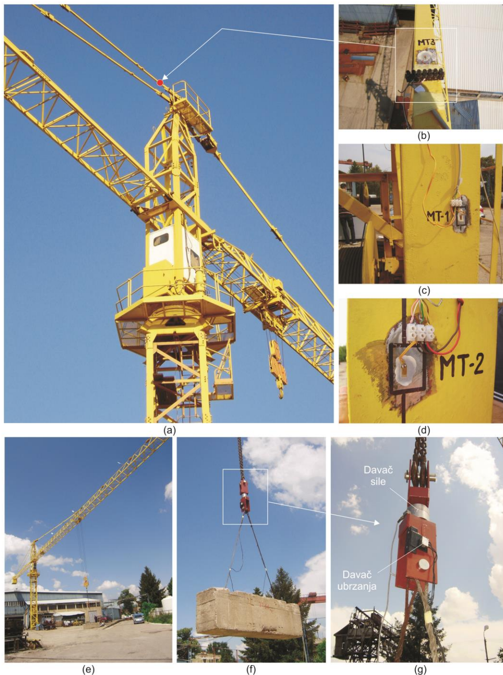
Slika 5.2 Foto zapisi sa merenja toranjske dizalice POTAIN-744E, MIN-KOPEX Niš, maj 2012: (a) Obrtni deo dizalice; (b) merna traka MT-3 na jednoj od dve zatege kontra-strele; (c) merna traka MT-1 na glavnom nosaču (levo) u podnožju tornja; (d) merna traka MT-2 na glavnom nosaču (desno) u podnožju tornja; (e) cela dizalica; (f) ispitni teret; (g) davači sile i ubrzanja.
