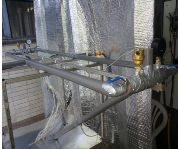
Слика 3.3 Сегмент хидрауличне инсталације на изводима размењивача топлоте
