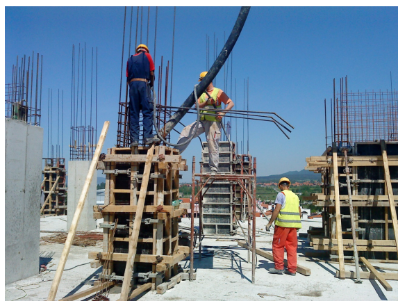
Слика 2.2 – Бетонирање АВ стубова (снимила: аутор рада)
