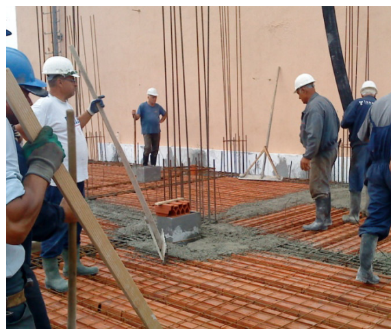
Слика 2.5 – Бетонирање „ферт“ плоче (снимила: аутор рада)
