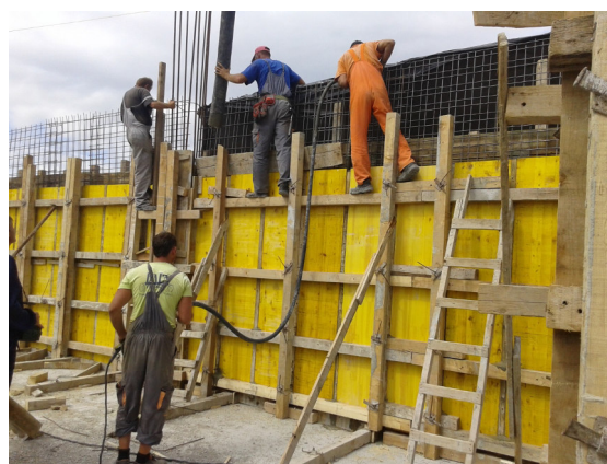
Слика 2.3 – Бетонирање АВ зидова (снимила: аутор рада)
