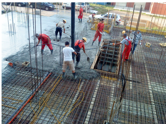
Слика 2.4 – Бетонирање пуне АВ плоче (снимила: аутор рада)
