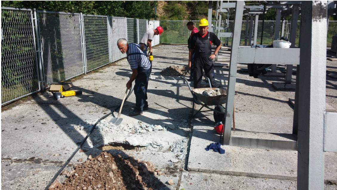
Slika 36 Otkopavanje u cilju verifikacije eksperimentalnih istraživanja (pozicije #59 i #60)
