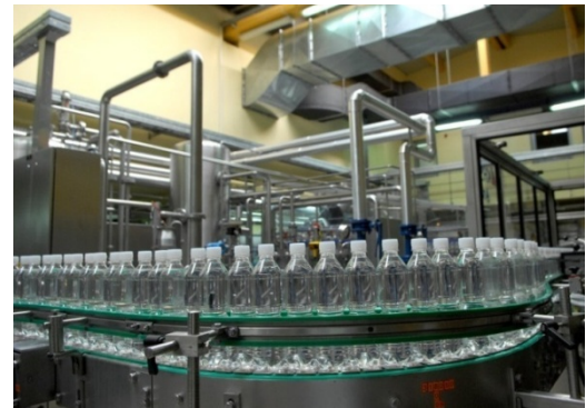
Slika 28. Pogon za proizvodnju pijaće vode Jazak 160
