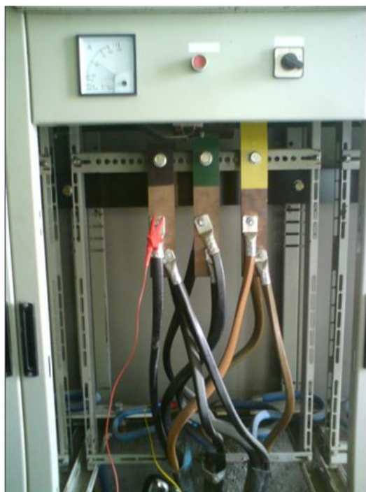
Slika 6.34. Oprema primenjena za snimanje signala i ilustracija povezivanja na blok transformatora
