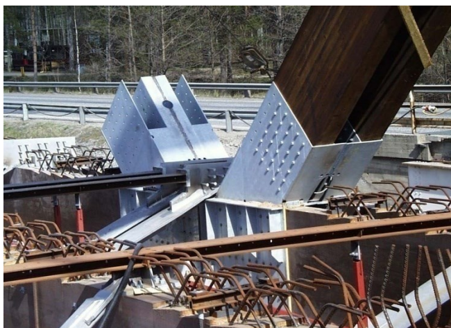
Slika 2.3.1 Posebna (slika levo) i standardna (slika desno) forma moždanika
