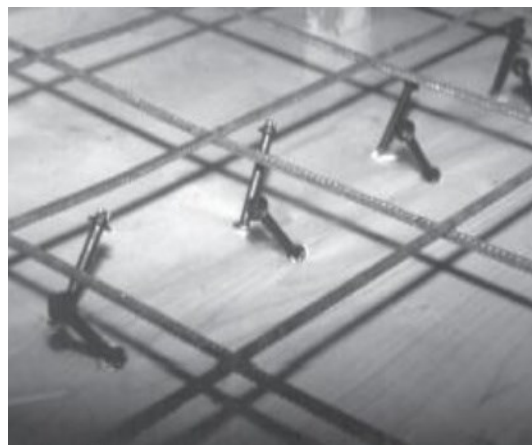
Slika 2.3.1 Posebna (slika levo) i standardna (slika desno) forma moždanika
