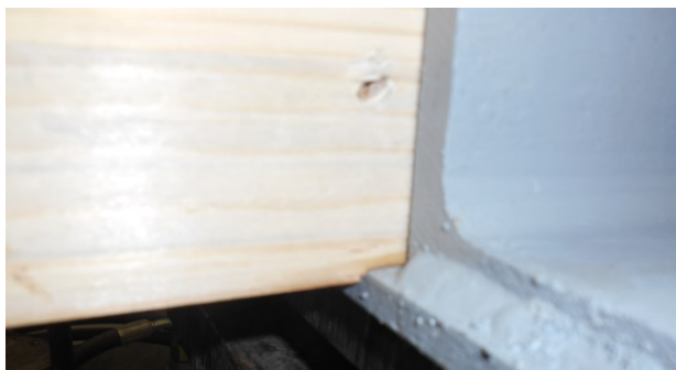
Slika 6.5.2.2 „Plastifikacija” drveta u zoni oslanjanja usled prekoračenja čvrstoće na pritisak upravno na pravac pružanja vlakana
