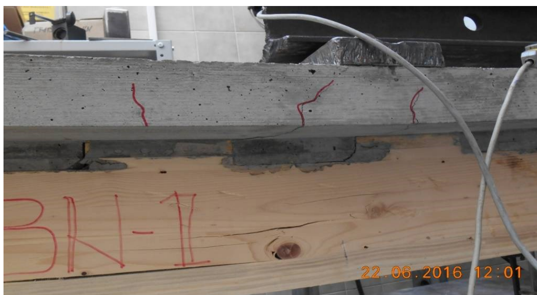
Slika 6.4.3.2 Lom grede BN-1, razvoj prslina u betonu i pukotina u drvetu
