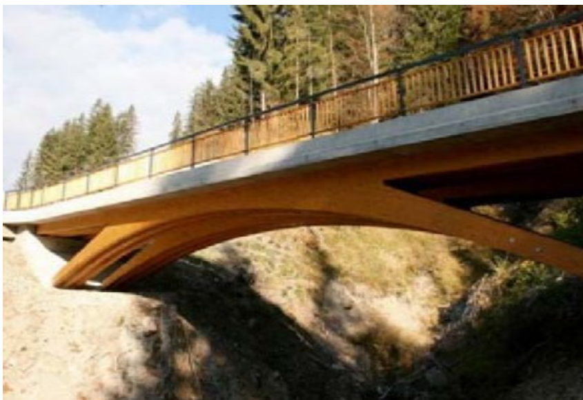
Slika 2.1.2 Spegnuta konstrukcija tipa drvo-beton drumskog mosta u Švajcarskoj
