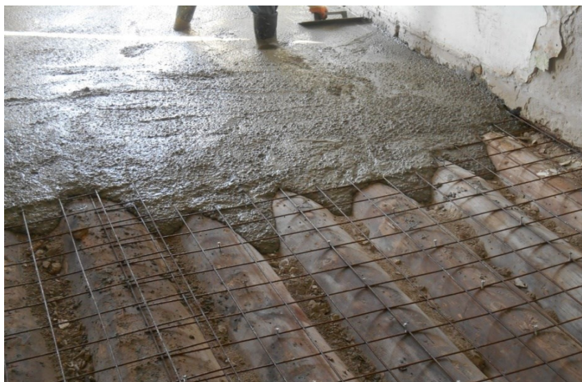
Slika 2.1.3 Ojačanje postojeće drvene međusprtane konstrukcije objekta sa statusom spomenika kulture, metodom sprežanja sa betonom (Srbija, R. Cvetković)
