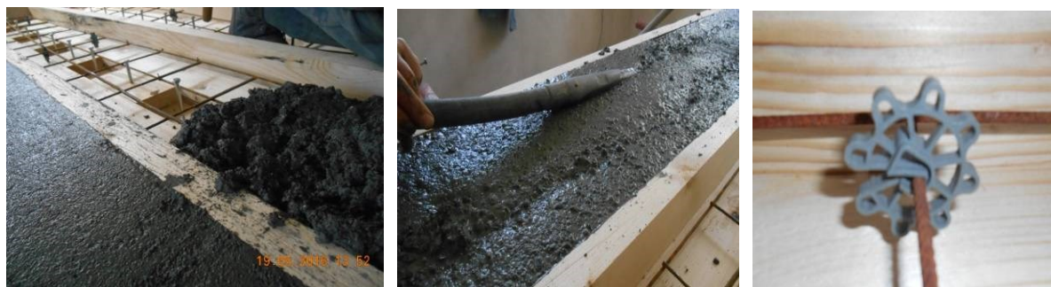
Slika 6.1.5 Ugradnja betona, distancirana armatura
