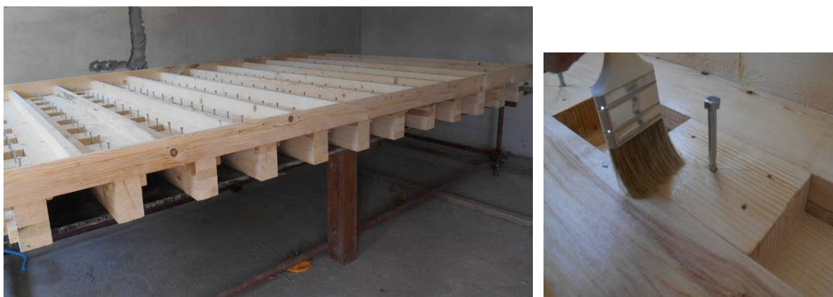
Slika 6.1.3 Platforma za izradu oplata spregnutih grednih nosača
