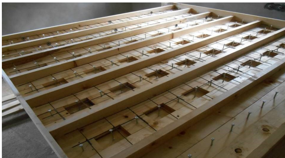
Slika 6.1.4 Oplate spregnutih grednih nosača pre betoniranja
