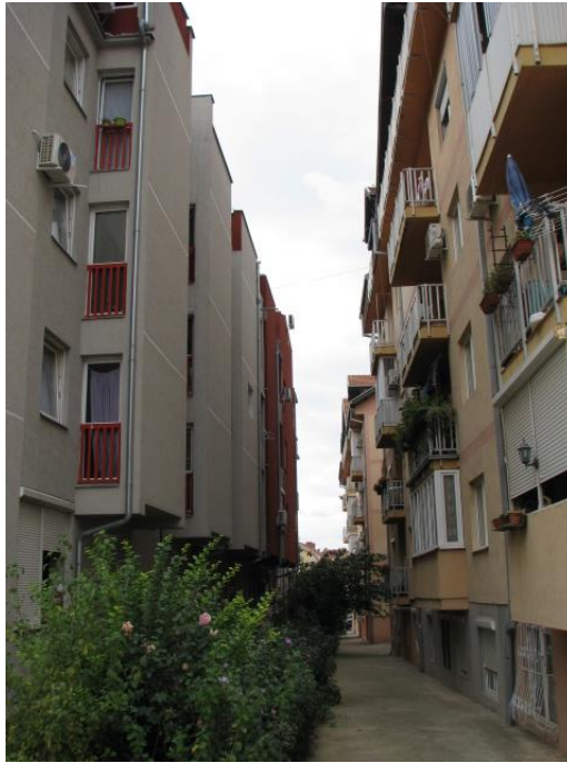
Слика 5.60: Изглед простора између објеката. Извор: аутор.
