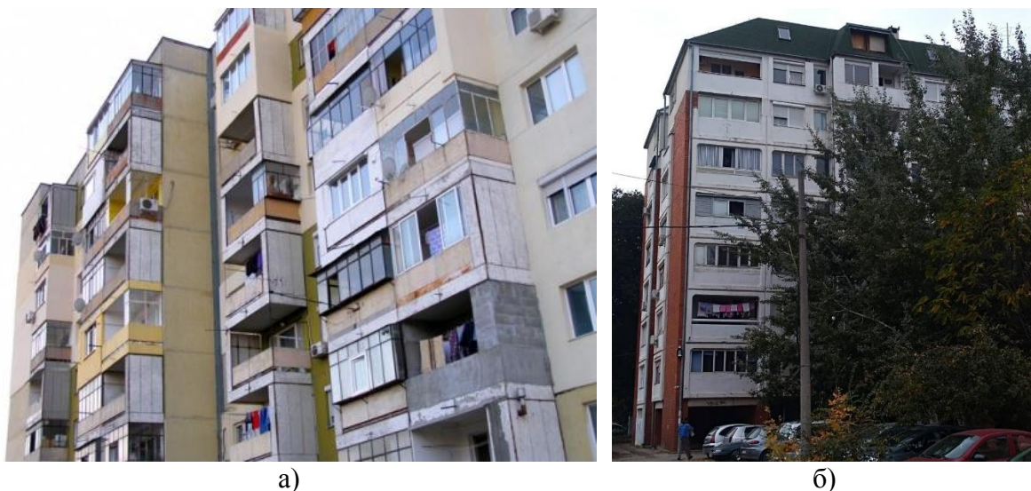
Слика 4.5: Проширење стамбеног простора: а) затварање балкона, Софија 24 ; б) надоградња стамбене зграде, Ниш. Извор: аутор.
