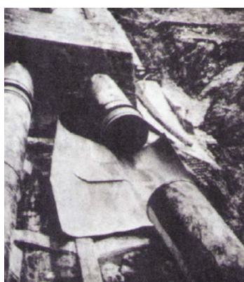
Slika 3.1 [3] Pucanje cevovoda na hidroelektrani Oigawa, Japan. (After Bonin, 1960.)
