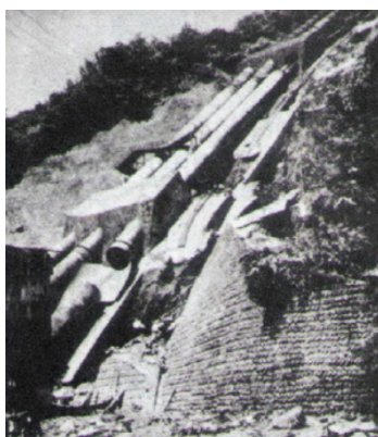
Slika 3.1 [3] Pucanje cevovoda na hidroelektrani Oigawa, Japan. (After Bonin, 1960.)
