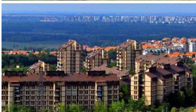
Slika 5.5 Primeri višeporodičnih stambenih zgrada građenih u IMS sistemu
