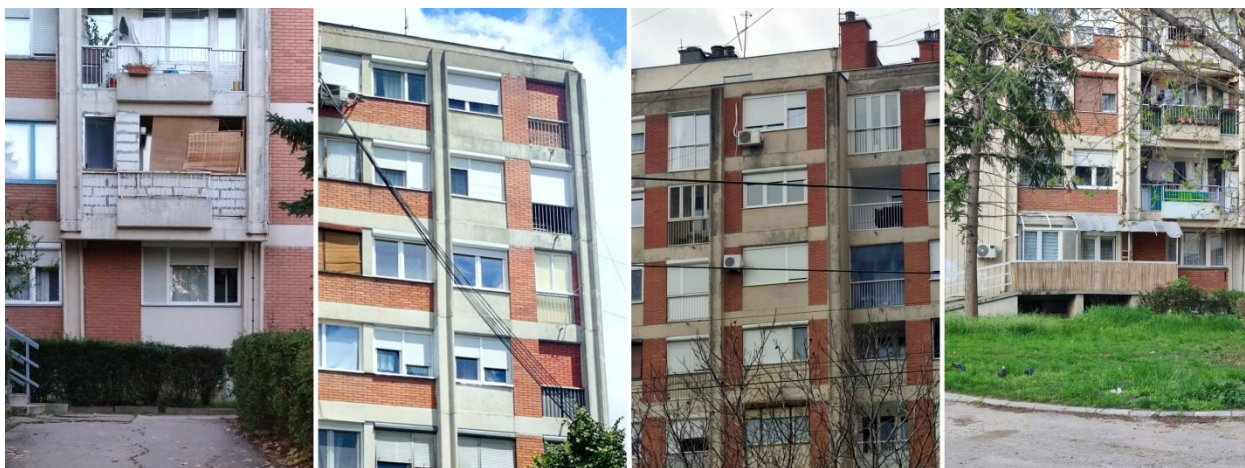
Slika 6.2 Proširenja manjeg obima u smislu zatvarnja postojećih balkona i lođa, i transformacija zajedničkih prostorija u stambeni prostor.
