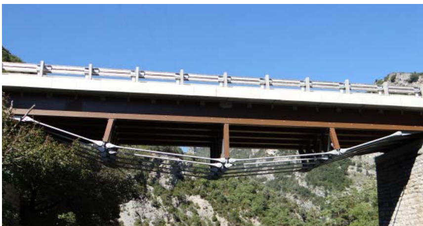
Slika 2.1.2.7 Ilonse Bridge (Francuska)
