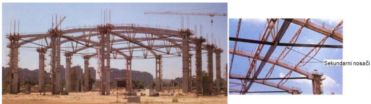
Slika 2.2.2.6 Izgled objekta po završetku montaže glavnih nosača
