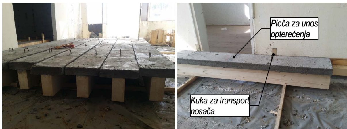
Slika 5.2.4 Nosači nakon demontaže oplata
