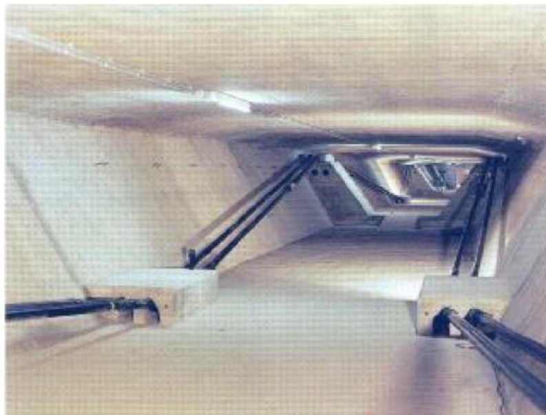
Slika 2.2.1.6 Vanjsko prednaprezanje AB mosta
