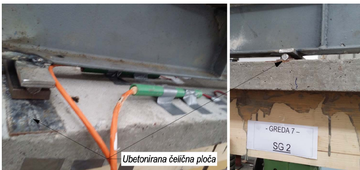
Slika 5.4.2.3 Čelične ploče u betonskom delu nosača
