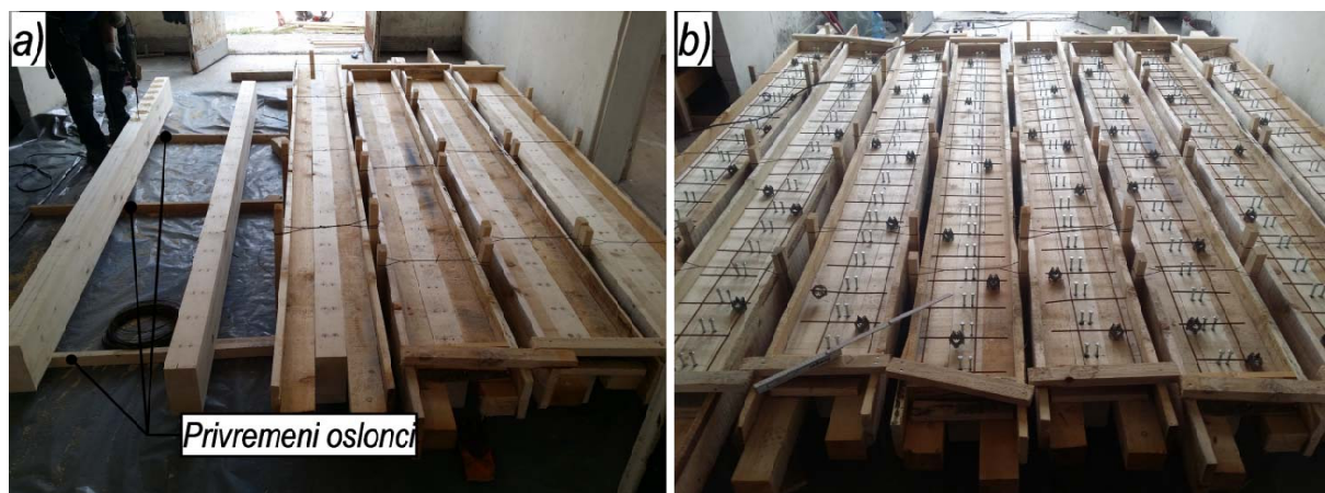
Slika 5.2.3 Priprema nosača za betoniranje, a) drveni nosači sa oplatom na privremenim osloncima i bušenje rupa u drvenom nosaču za ugradnju moždanika, b) nosači spremni za betoniranje
