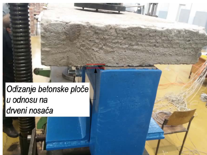
Slika 5.4.4.8 Odizanje betonske ploče u odnosu na drveni nosač
