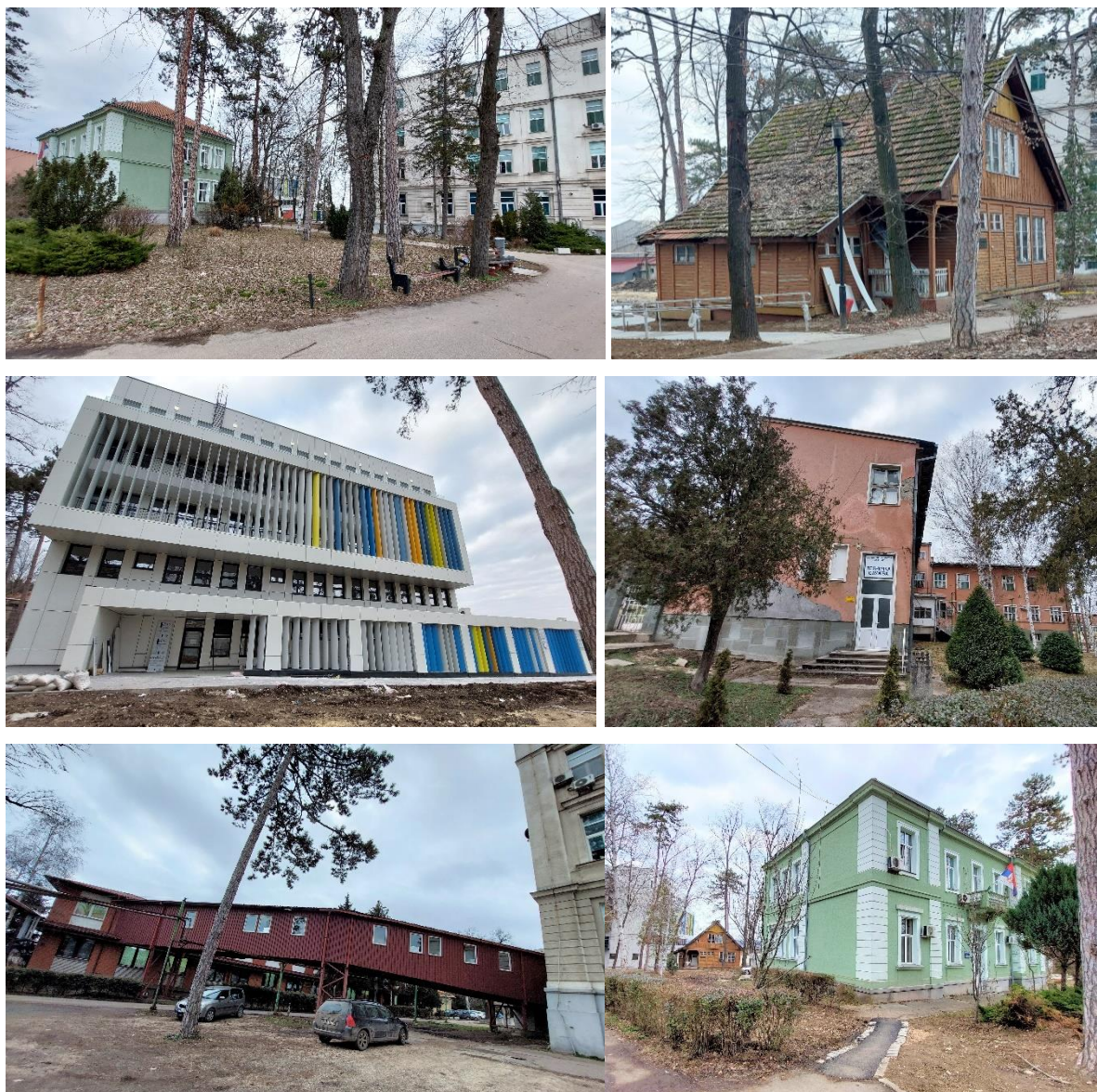
Слика 128 – Данашњи изглед комплекса Здравственог центра Зајечар
