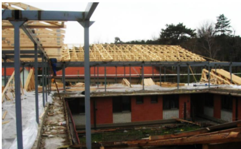
Слика 127 – Реконструкција и надоградња Интерног одељења изнад Инфективног одељења, постављање челичне конструкције, 2008. г.
