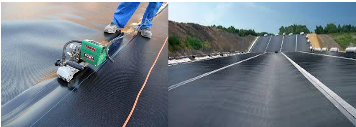
Слика 5.3 Варење и постављање HDPE фолије
