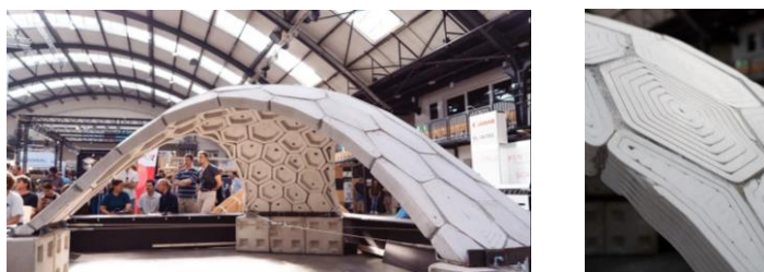
Слика 2-4. Хекастоне павиљон од 3Д штампаних модула на сајму компактних конструкција у северној Европи у Нојминстеру, Шлезвиг Холиштајн (лево), детаљ споја елемената (десно) (Vertico, 2023)
