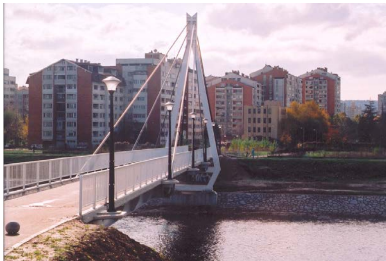
Slika 5.4.2 Pogled na most sa nizvodne strane
