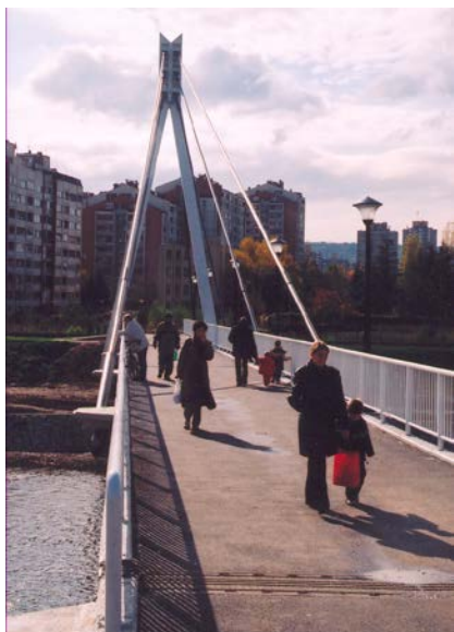
Slika 5.4.1 Pogled na most
