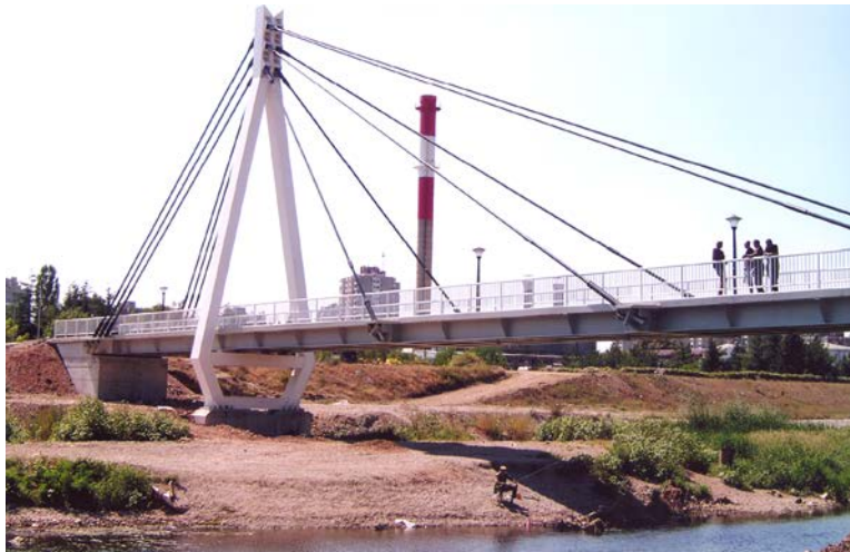
Slika 5.4.5 Pogled na pilon mosta sa uzvodne strane
