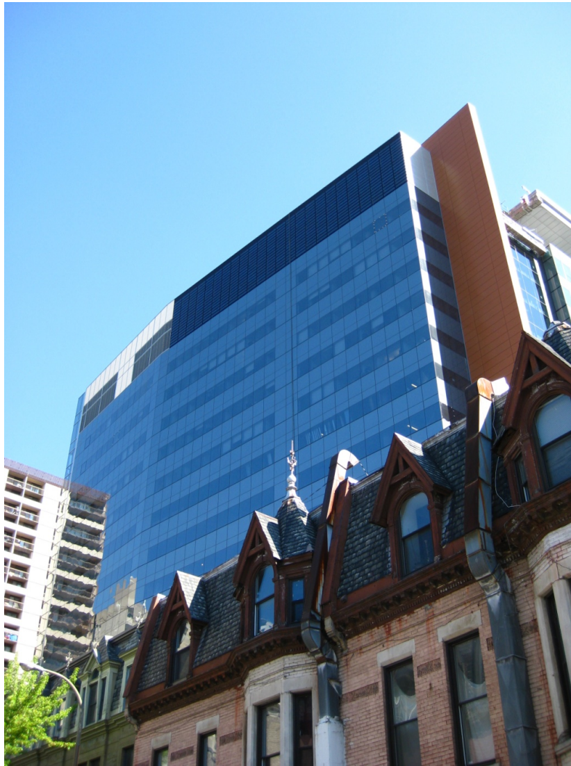
Сл. 5.1.33 Архитектонска интеграција хибридних фотонапонско-термалних панела у фасаду зграде John Molson School of Business, Универзитет Конкордија, Монреал, Канада (Извор фотографије: http://sbrn.solarbuildings.ca/main.php?t=demoprojects&i=2&ext=&l=e&d=1 )
