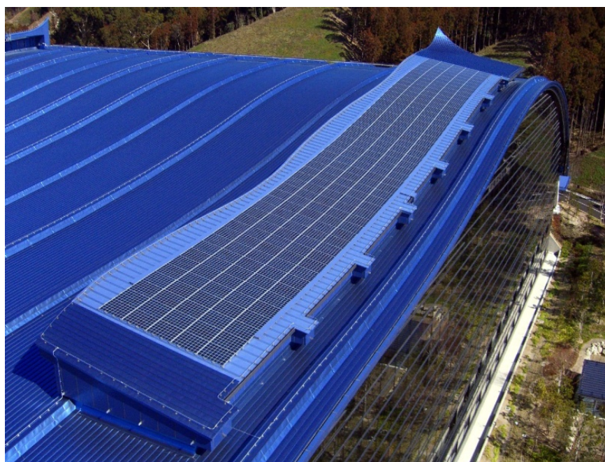
Сл. 5.1.31 Детаљ фотонапонског крова Куусуи националног музеја, Фукуока, Јапан (Извор фотографије: http://www.pvdatabase.org/projects_view_details.php?ID=224 )
