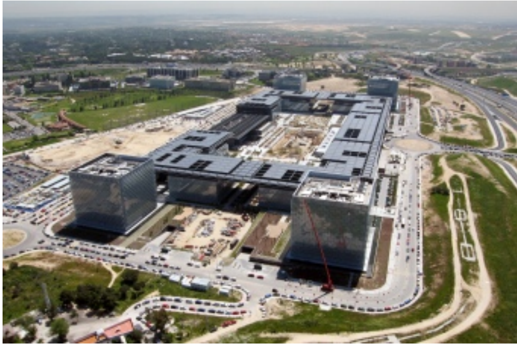
Сл. 5.1.26 Зграда Telefonica C District, Мадрид, Шпанија (Извор фотографије: www.pvdatabase.org/projects_view_details.php?ID=298 )
