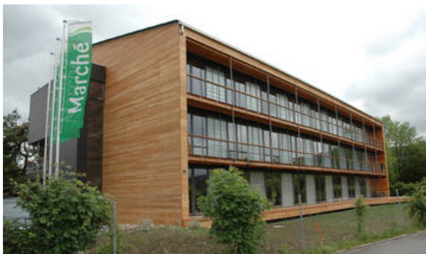
Сл. 2.2.3.3.1 Пословна зграда у Кемпталу, Швајцарска. (Извор фотографије: http://www.minergie.ch/buildings/en/details.php?gid=ZH-003-P-ECO. )
