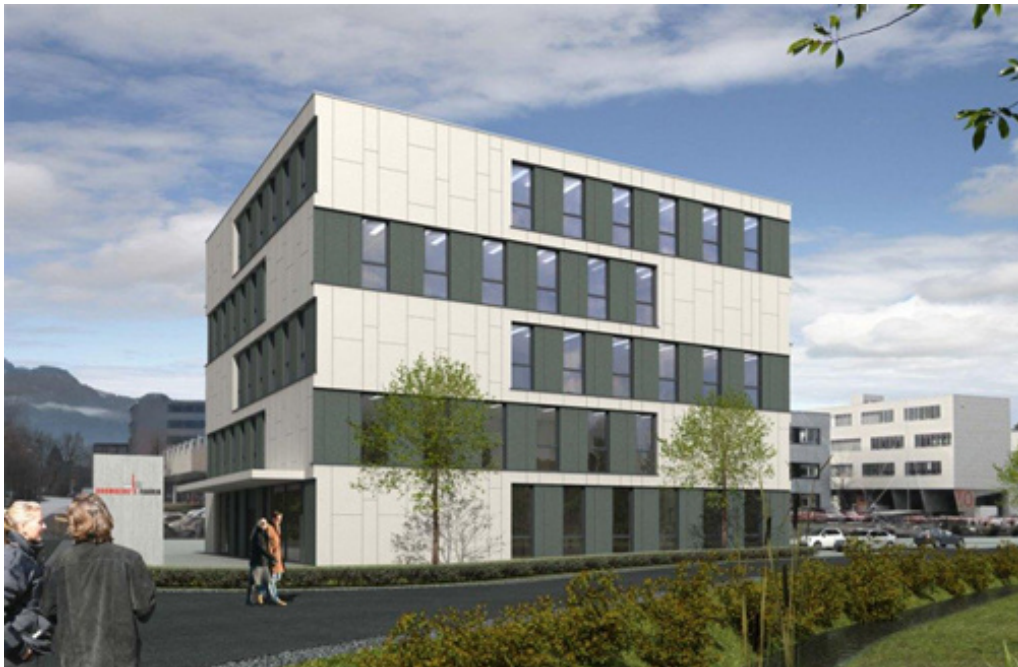
Сл. 2.2.2.1.1 Пословна зграда QUADRA. (Извор слике: http://www.inet-logistics.com/en/press/inet-in-the-news/inet-rhomberg-celebrate-topping-of-quadra-office-building .)
