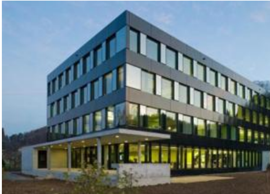
Сл. 2.2.3.6.1 Пословна зграда у Фламату, Швајцарска. (Извор фотографије: http://www.minergie.ch/buildings/en/details.php?gid=FR-313 .)
