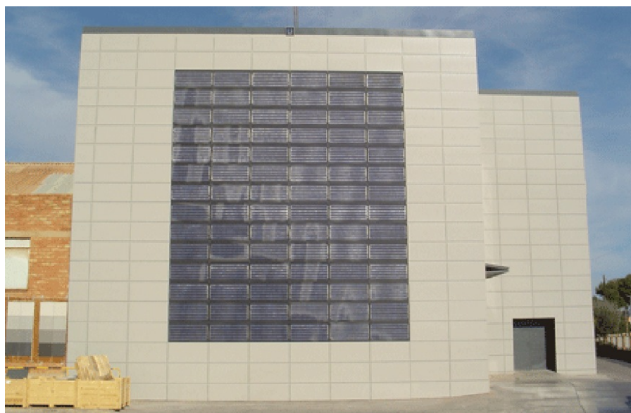
Сл. 5.1.20 Фотонапонско-керамичка вентилирајућа фасада на згради Tau Ceramica, Кастељон, Шпанија (Извор фотографије: http://www.pvdatabase.org/projects_view_details.php?ID=337 )
