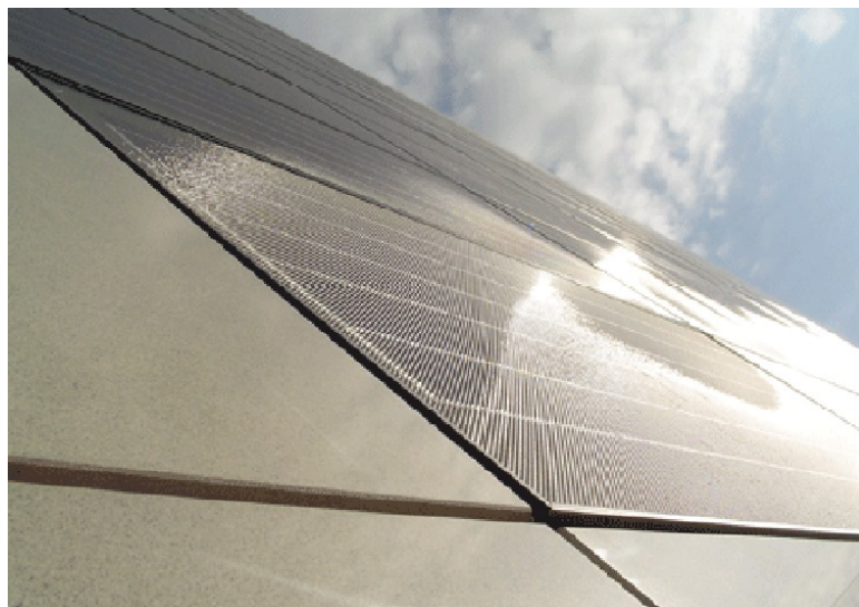
Сл. 5.1.21 Детаљ фотонапонско-керамичке вентилирајуће фасаде на згради Tau Ceramica, Шпанија (Извор фотографије: http://www.pvdatabase.org/projects_view_details.php?ID=337 )
