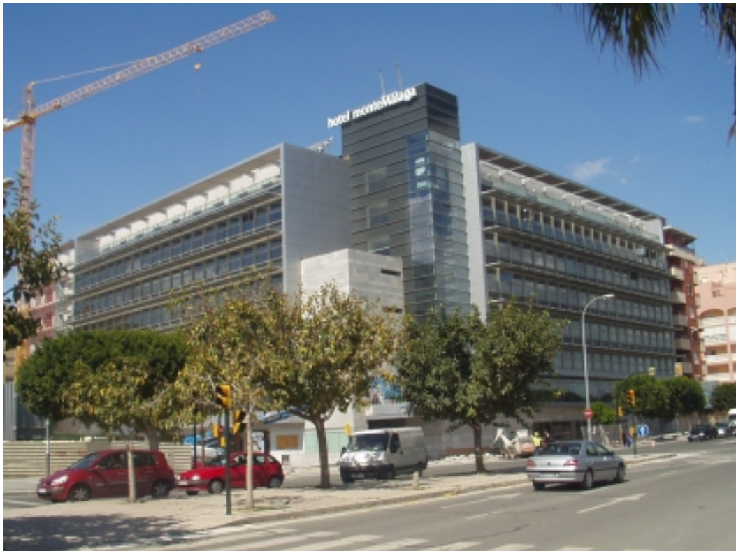
Сл. 5.1.14 Хотел Monte Malaga, Малага, Шпанија (Извор фотографије: www.pvdatabase.org/projects_view_details.php?ID=297 )
