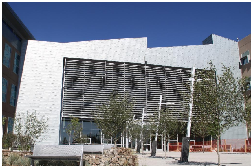
Сл. 2.2.1.4.2 Истраживачки институт NREL, спољашњи брисолеји (извор фотографије: http://buildipedia.com/aec-pros/design-news/nrels-research-support-facilities-strive-for-net-zero-energy ).
